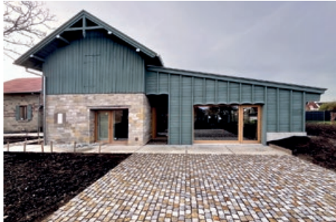
Ancienne grange et extension de la maison forestière, buob architecte, 2024 © buob architecte
