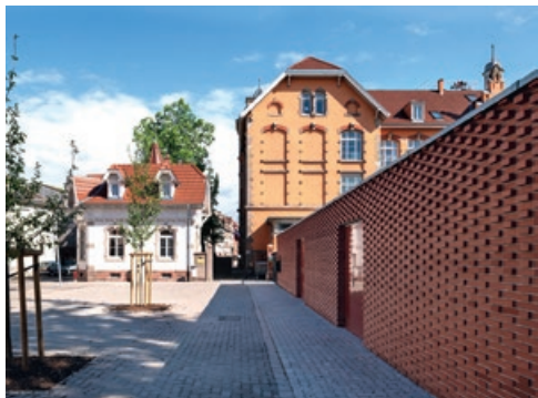
Rénovation du groupe scolaire Schluthfeld, Neudorf, Rey-de Crécy atelier d'architecture © Valérie Trégan
