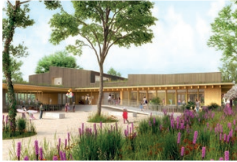
Groupe scolaire de Rountzenheim-Auenheim, DWPA Architectes © Stéphane Castets
