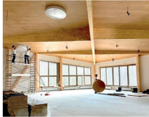
École Mentelin, chantier intérieur, MW & feld72 © MW architectes
