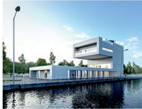
Vue depuis l'écluse, DWPA architectes, en chantier © Ilulissa Images
