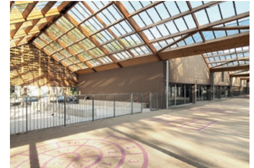
Transformation du groupe scolaire Gustave Doré, TOA architectes associés © TOA architectes associés
