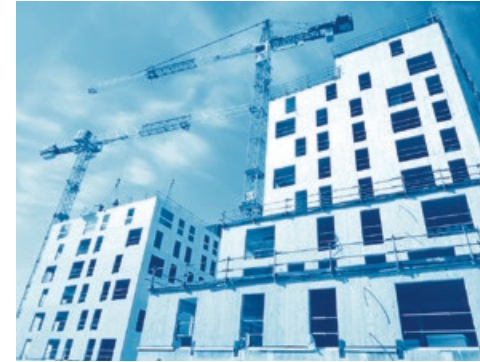
Chantier du bâtiment «Sensations» © KOZ Architectes-ASP Architecture
